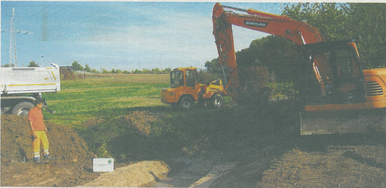
Der Salzgraben erhält sein ursprüngliches Gelände wieder.
